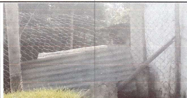
Foto 6: Reparación de tubo hg y malla galvanizada
