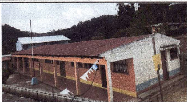
Foto 1: Sustitución de lamina, por lámina torquelada Aluzinc calibre 26
