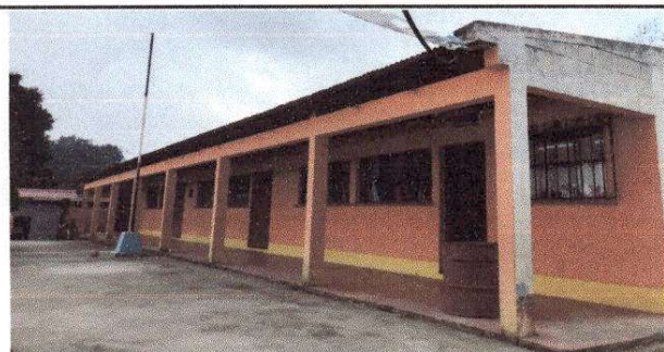
Foto 5: Sustitución de canal de metal (lugar donde se colocaran los canales y bajada de agua pluvial, tubo PVC 3"a).
